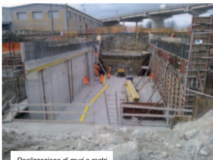
Realizzazione di muri e rostri
