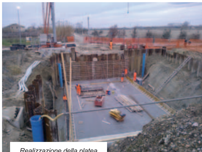
Realizzazione della platea
