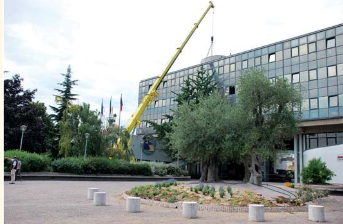
L'installazione dei nuovi condizionatori
