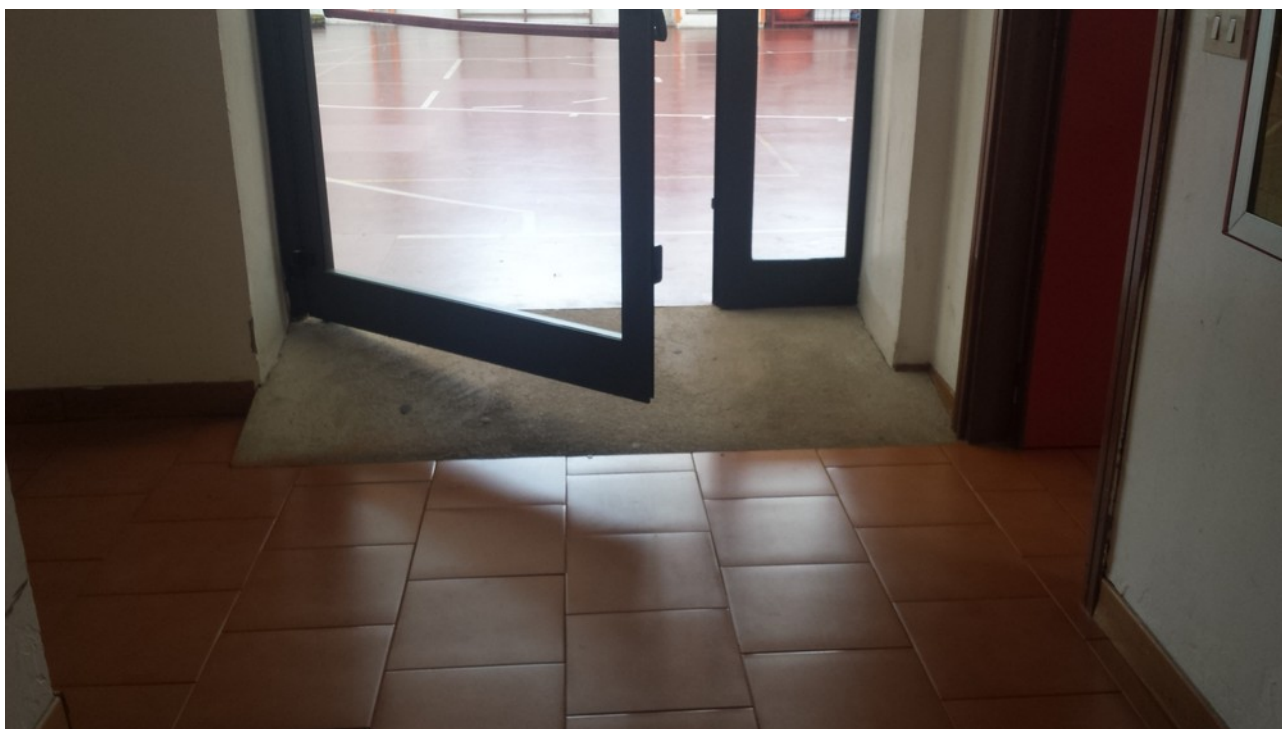
Dislivello zona ingresso palestra – corpo spogliatoi
