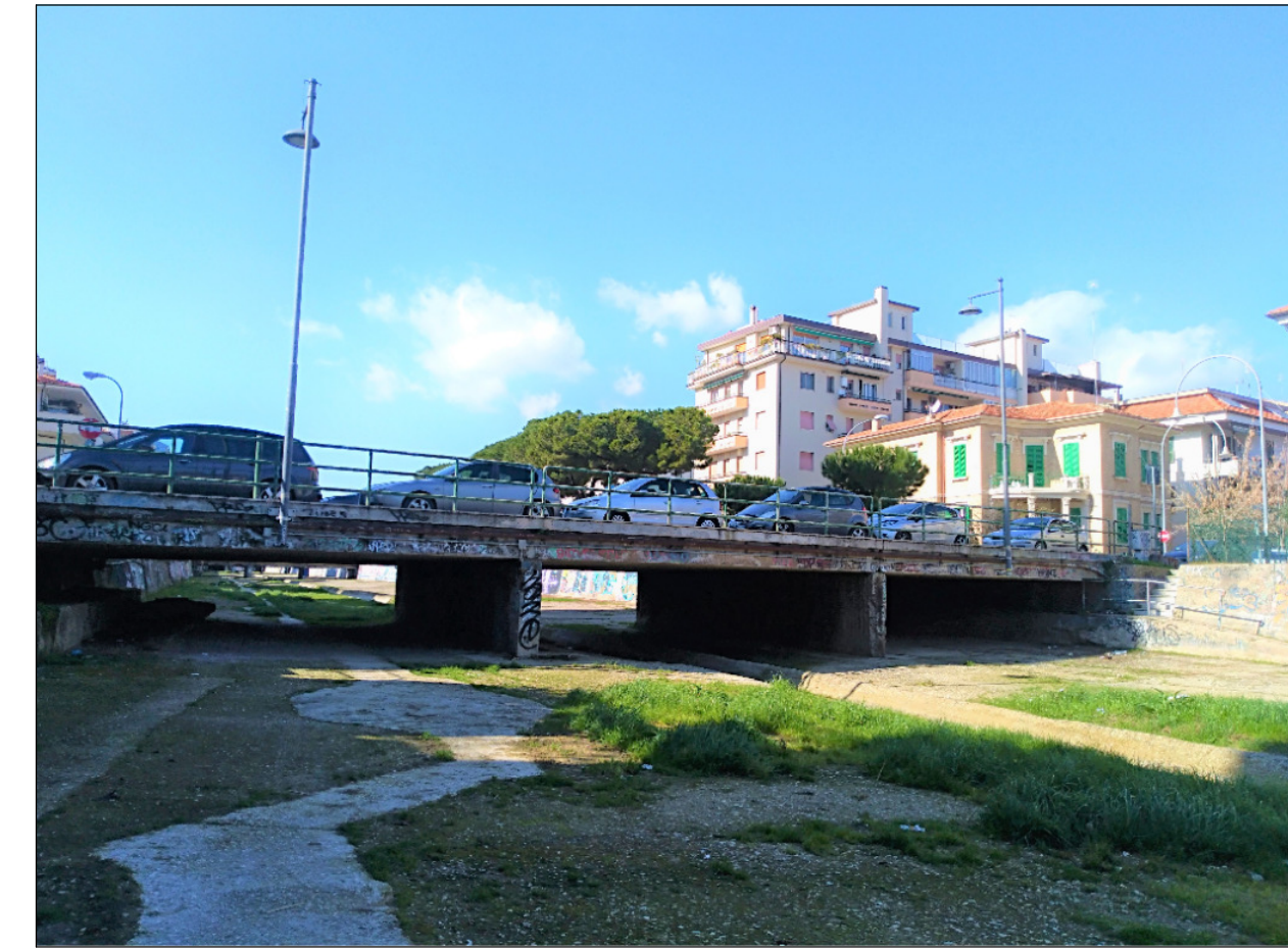
FOTO PONTE di via PIEMONTE lato VALLE
