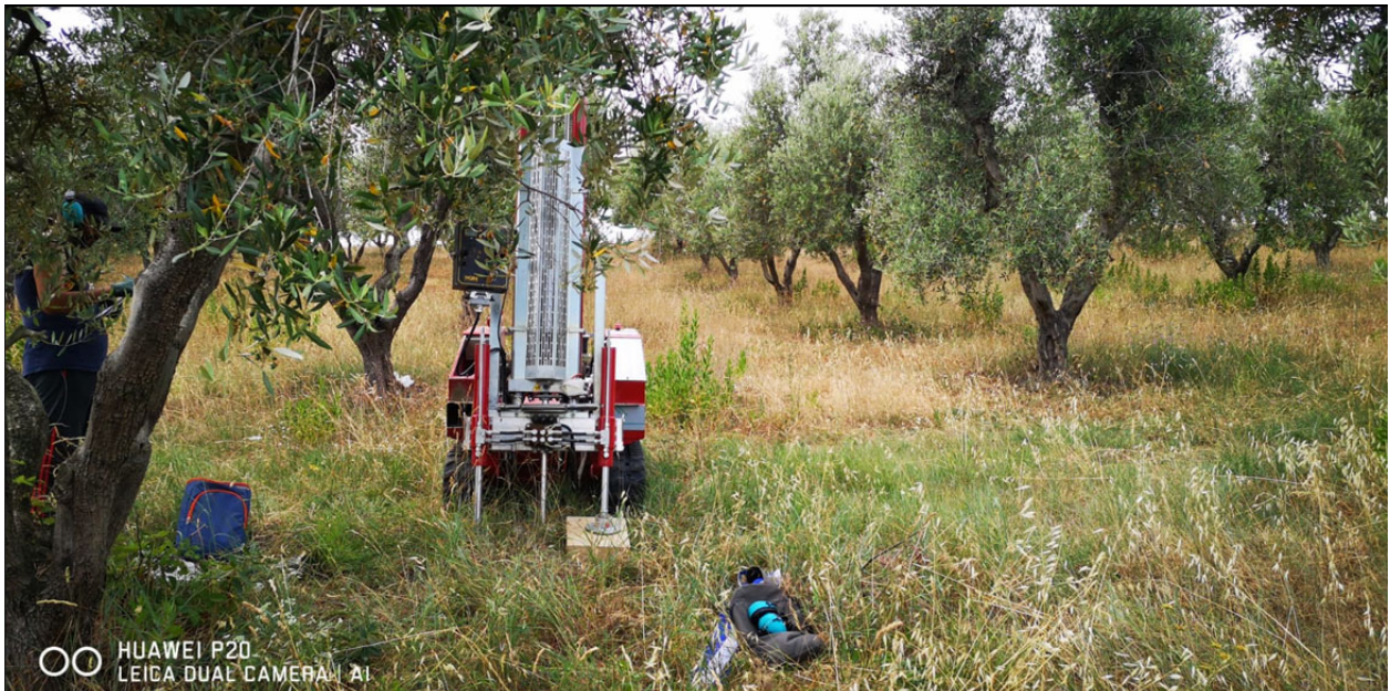
Figura 4 - Ubicazione dell'indagine geotecnica DPSH P6 (vista verso ovest).
