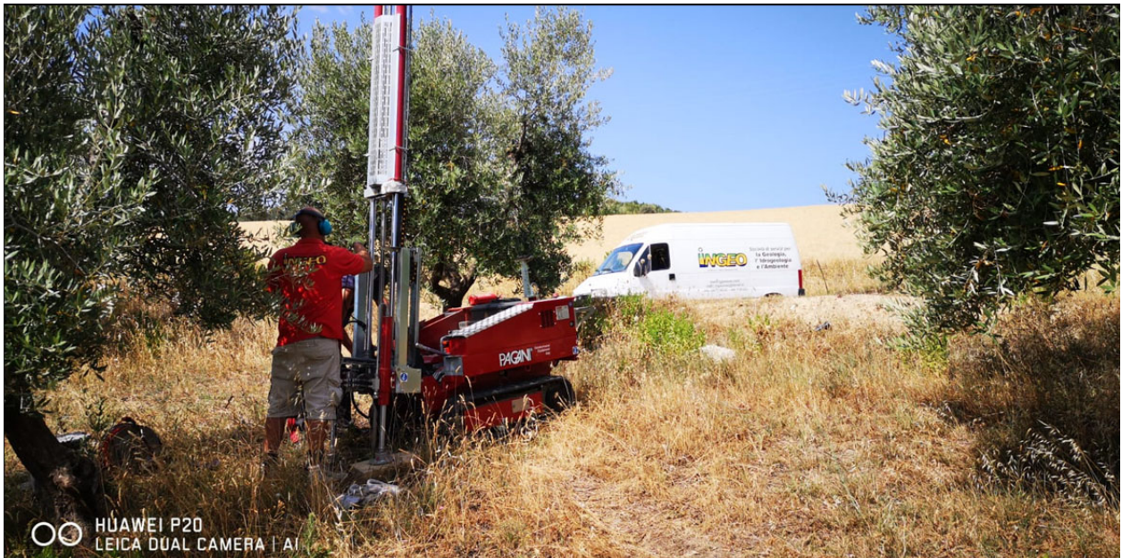
Figura 1 - Ubicazione dell'indagine geotecnica DPSH P5 (vista verso ovest).
