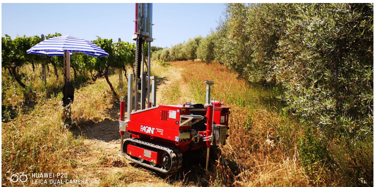
Figura 6 - Altro punto di vista (vista verso ovest).
