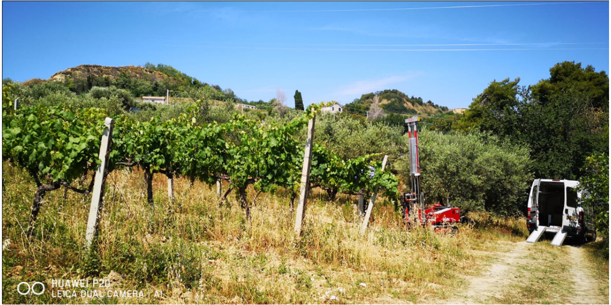
Figura 7 - Altro punto di vista (vista verso ovest, nord-ovest).
