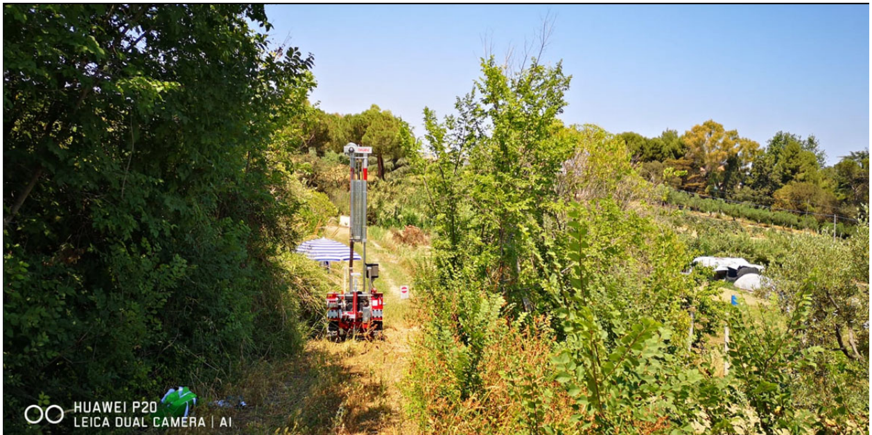
Figura 10 - Ubicazione dell'indagine geotecnica DPSH P3 (vista verso nord).
