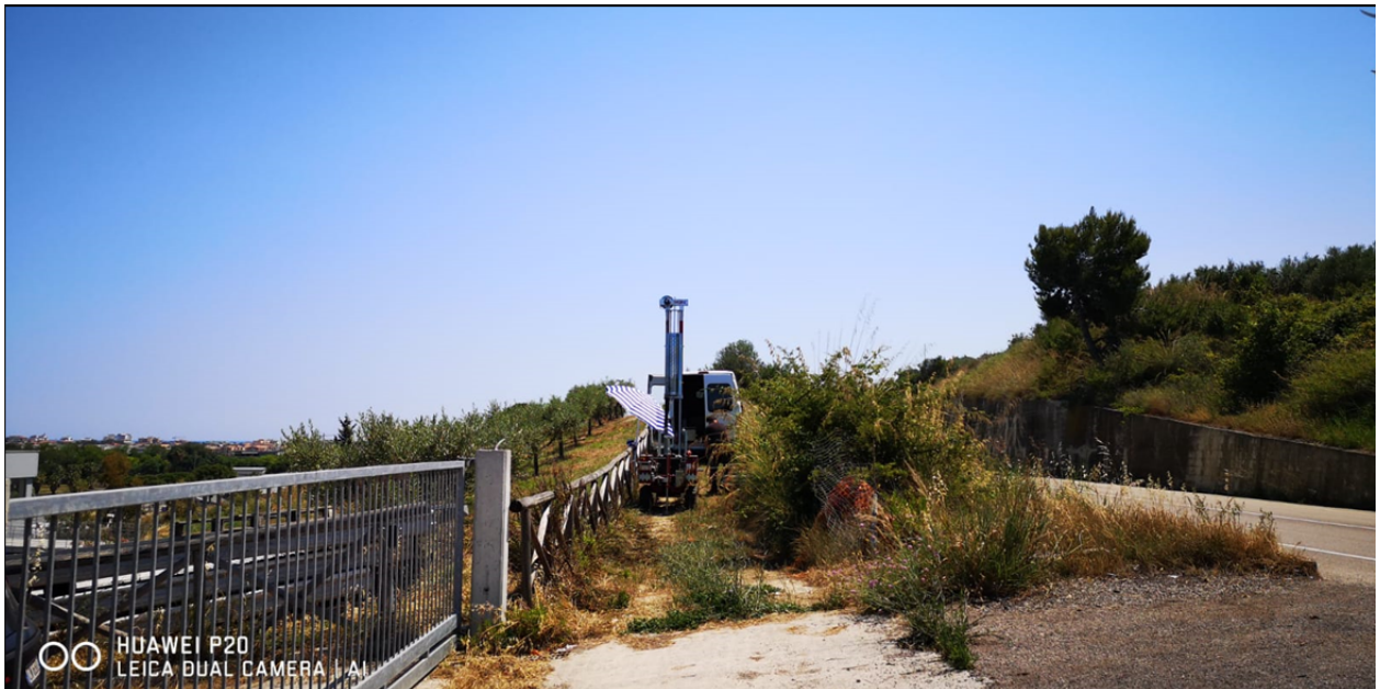
Figura 13 - Ubicazione dell'indagine geotecnica DPSH P4 (vista verso sud).
