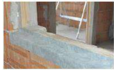
Tre diverse tipologie di applicazione per sigillatura ed impermeabilizzazione del lato inferiore del falso telaio
