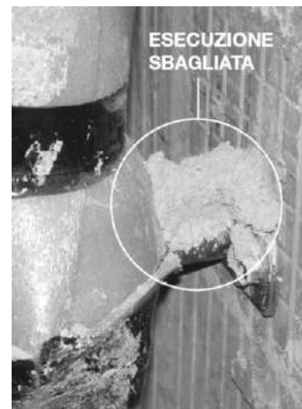
Figura 10.6- B) trasmissione delle vibrazioni attraverso un ponte di malta
