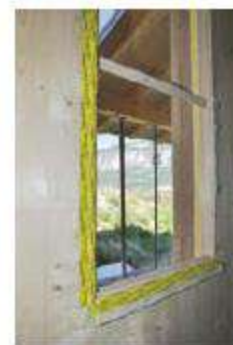
USB Tape 1 PAP X3 a sigillatura tra falsotelaio e parete in legno
