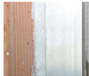
USB Foam tra muratura e falso telaio
