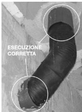
Figura 10.5 - A) disaccoppiamento realizzato con guaina isolante Geberit.
