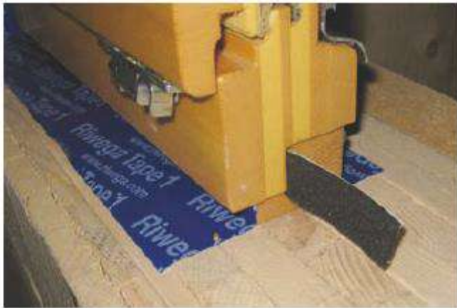
GAE UNIVERSAL tra serramento e falsotelaio
