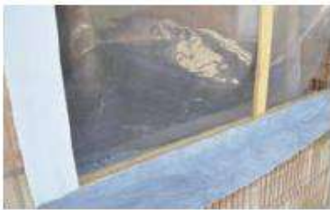
Tre diverse tipologie di applicazione per sigillatura ed impermeabilizzazione del lato inferiore del falso telaio
