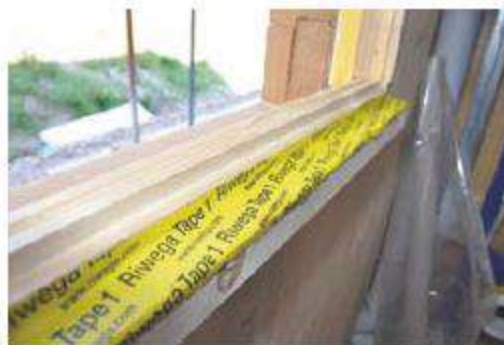
USB Tape 1 PAP X3 a sigillatura tra falsotelaio e parete in legno
