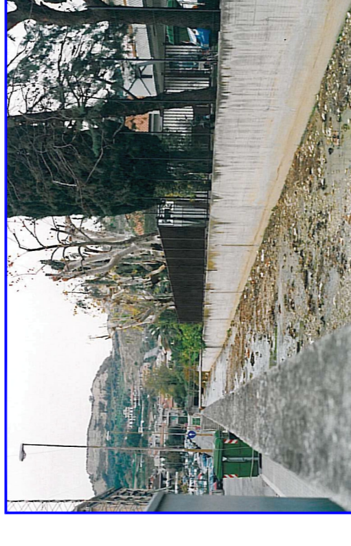
Foto n°6: La foto, presa da valle, mostra il tratto del Fosso della Fornace con argini e fondo rivestito in c.a.
