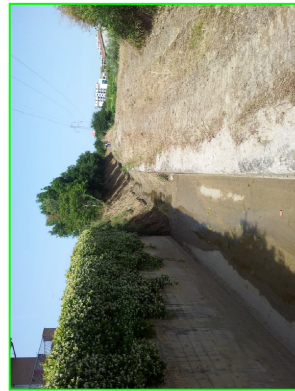
Foto n°1: La foto mostra il tratto dell'alveo a valle della S.S. n°16, dopo i recenti lavori di pulizia e taglio della vegetazione. Si osserva in primo piano il tratto rivestito e proseguendo il tratto in terra, con i potenti argini.
