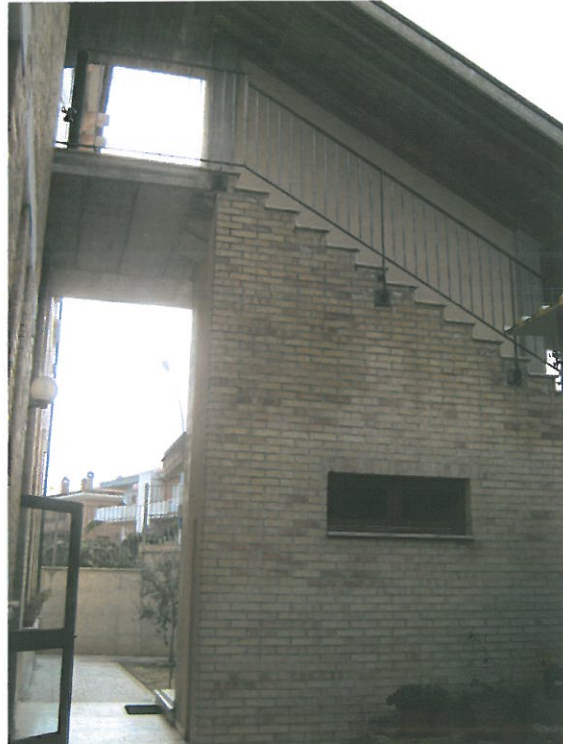
Scala Esterna e ripostiglio
