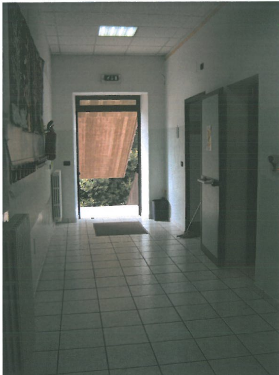
Interni corridoio Piano Primo
