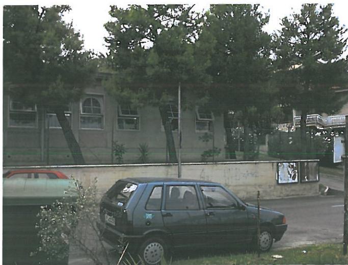
Fronte Est (porzione nord)
