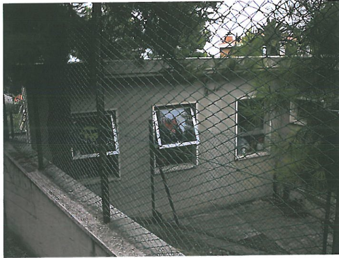
Fronte Ovest (porzione nord)
