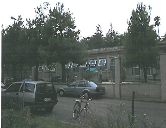
Fronte Est (porzione sud)
