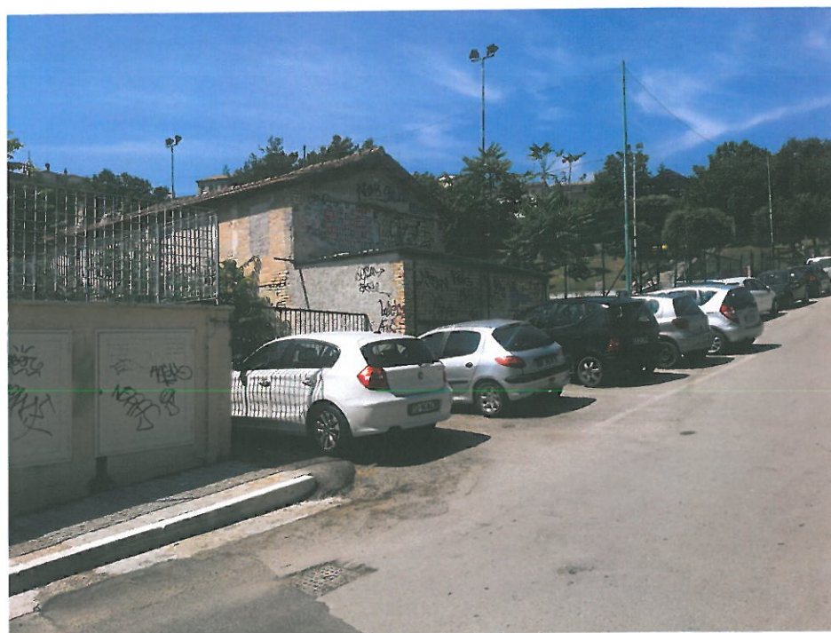
FRONTE DELL'IMMOBILE SULLA VIA SAFFI
