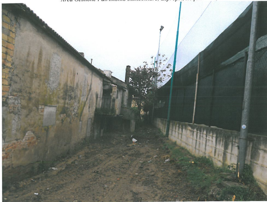
FRONTE OVEST DELL'IMMOBILE (CONFINE CON IL PARCO)
