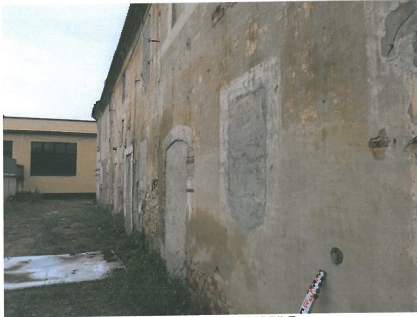
LATO EST DELL'IMMOBILE
