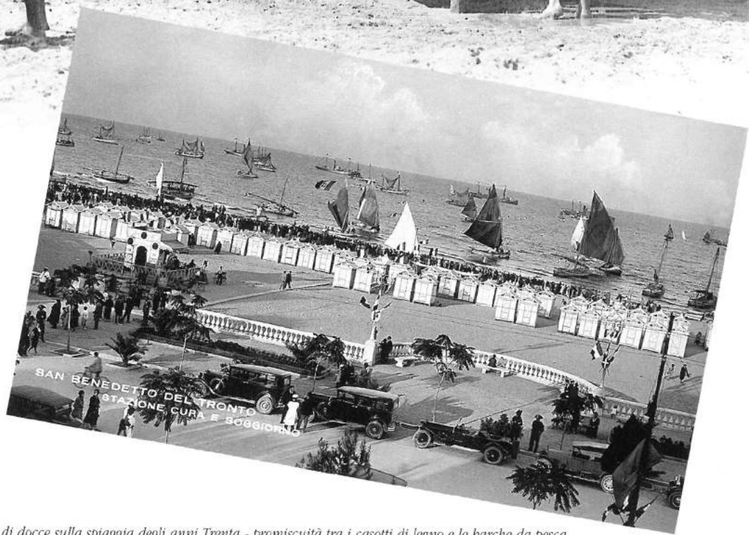
"Artistico" impianto di docce sulla spiaggia degli anni Trenta - promiscuità tra i casotti di legno e le barche da pesca.
