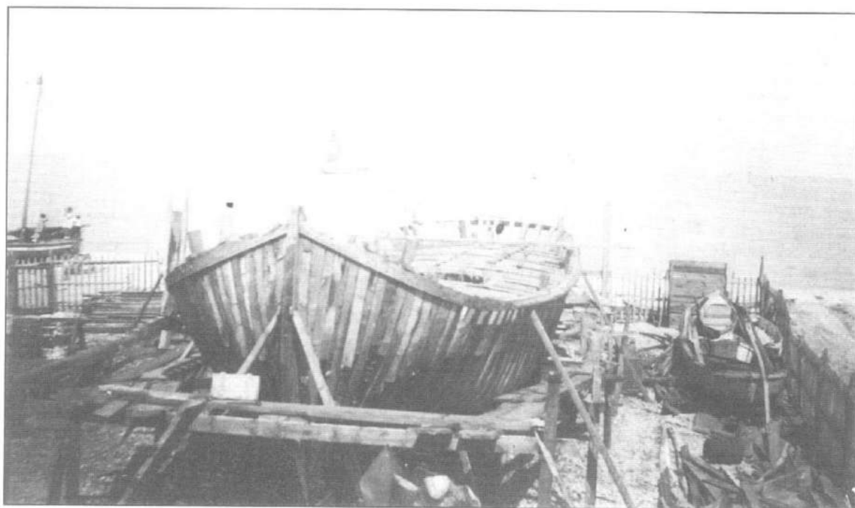
Motopeschereccio tipo trabaccolo in costruzione.
