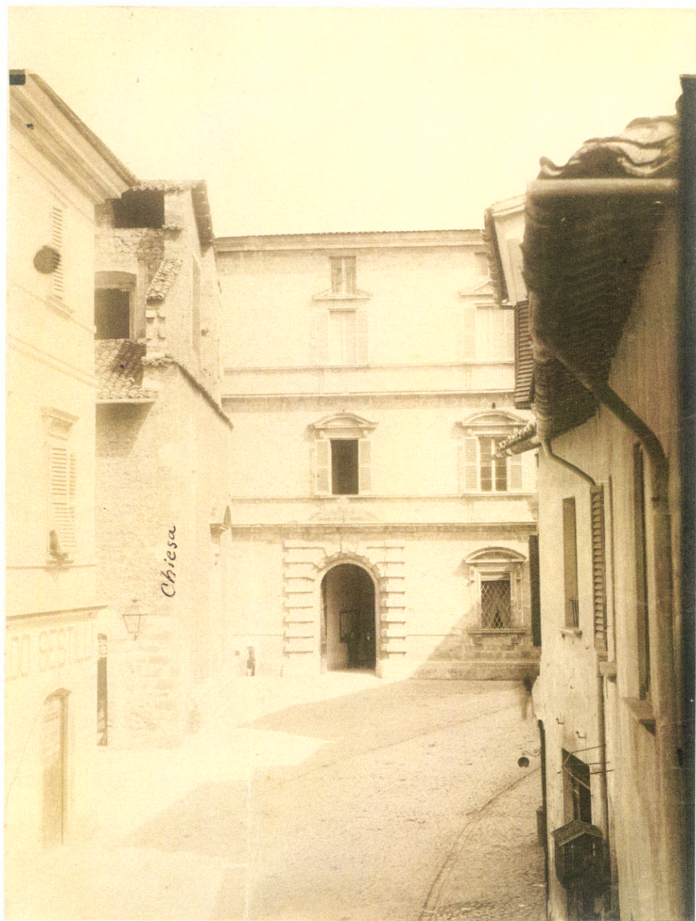
Ascoli Piceno - Complesso dei Filippini e Chiesa attigua
